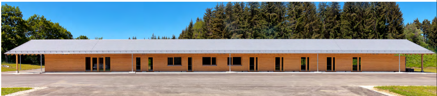
Unten: Aufenthalts-, Werkstatt- und Lagergebäude zur Standortschießanlage der Bundeswehr in Donaueschingen.
