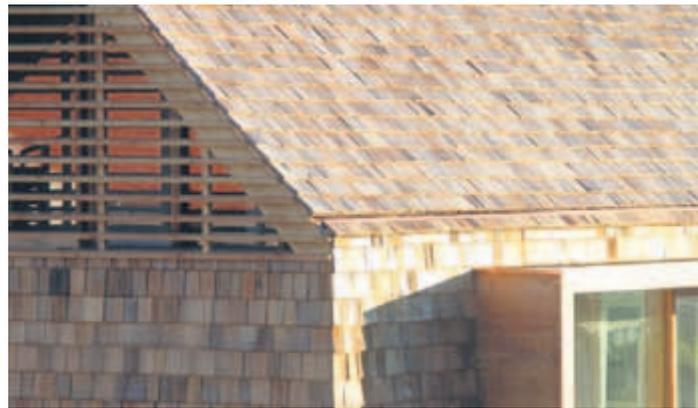
**Neubau mit Altbau in Gengenbach.** Dieser Holzrahmenbau mit Satteldach ist ein bis auf die Grundformen reduzierter Baukörper, dessen Flächen einheitlich mit einer Verschalung aus Rotzederschindeln überzogen sind. Fotos: Promo lehmann\_holz\_bauten
