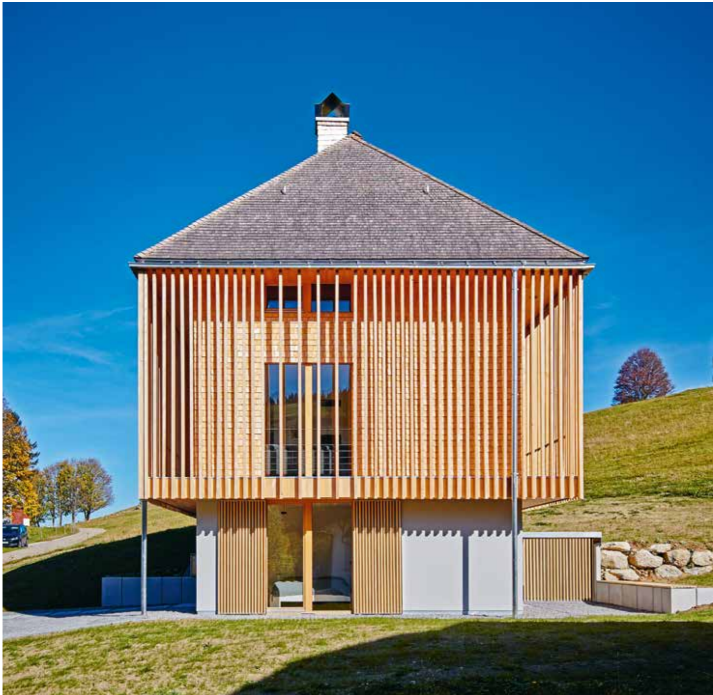
Der massive Kern des Gebäudes zieht sich unter der Holzkonstruktion von Obergeschoss und Dachgeschoss zurück, der Lamellenvorhang, der sich bei allen Öffnungen des Gebäudes bewegen lässt, wurde auch im Untergeschoss realisiert. Rechte Seite: Der Raum, dem der Lamellenvorhang vorgelagert ist, ist rund um das Gebäude begehbar.
