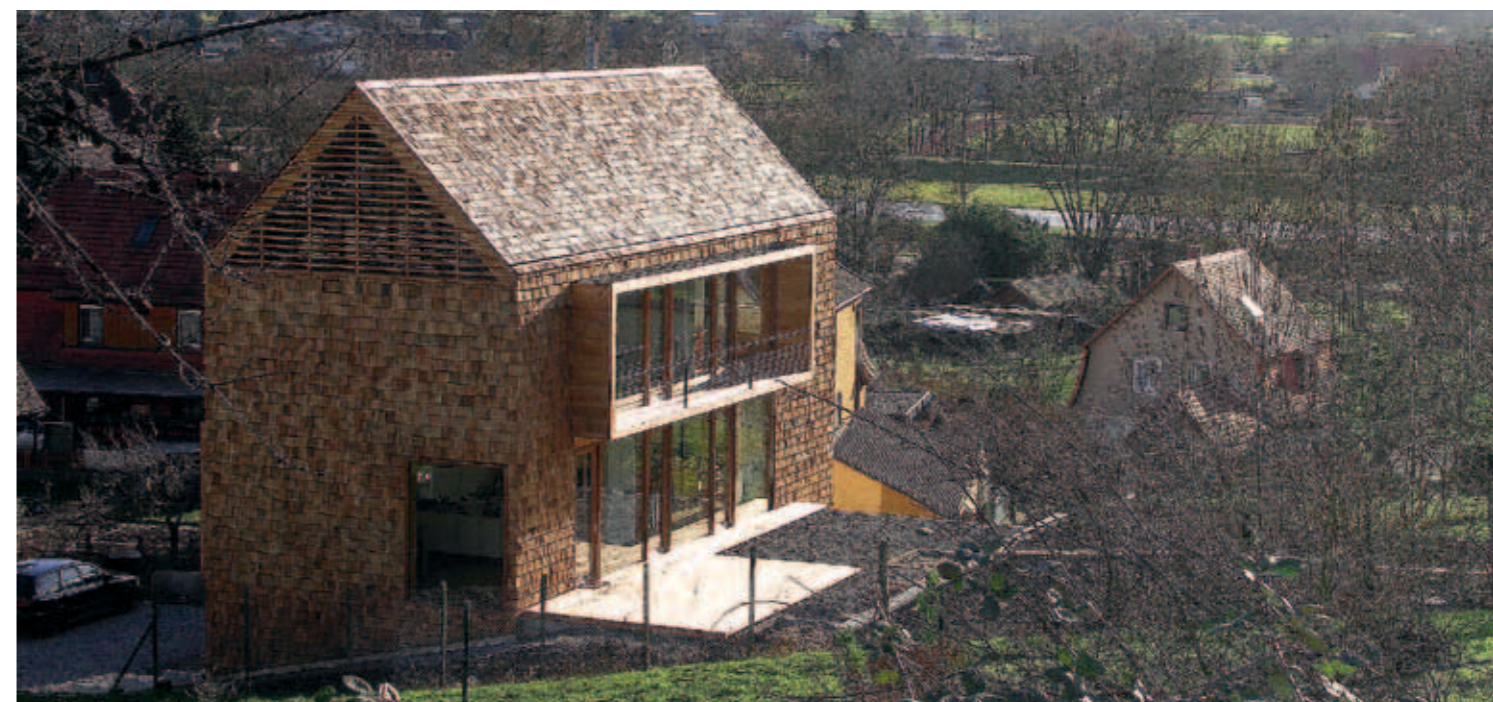
Wohnhaus in Gengenbach: Lehmanns Arbeiten bespielen die ganze Klaviatur der Holzbauarchitektur, hier das sachlich-klare unter Verwendung einheimischer Baumaterialien.
